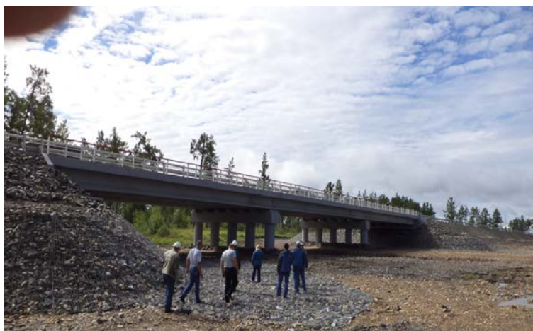
Мостовой переход через р.Желтая
