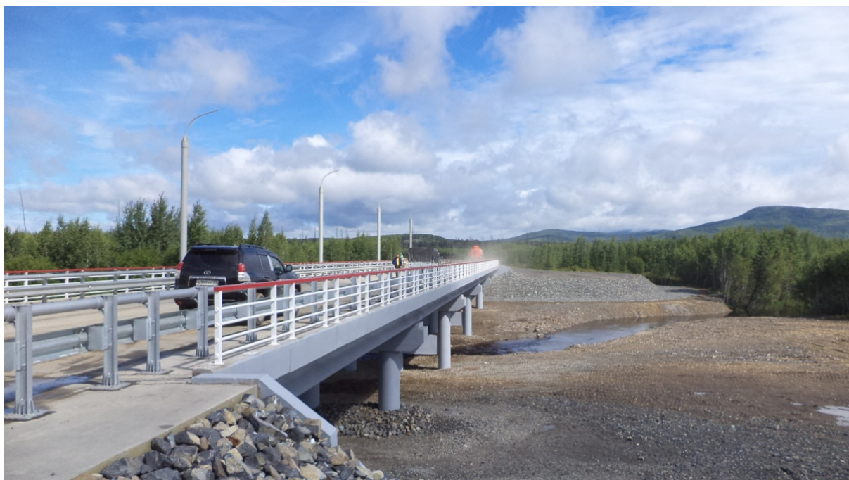
Мостовой переход через р.Уликагут.
